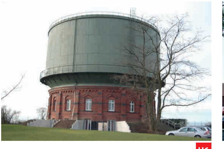
Kauen- und Verwaltungsgebäude der Zeche „Recklinghausen“ I, Hohenzollerstraße 66 Wasserturm, Ostschweg 160 Landmarke von 22 m Höhe auf dem Quellberg (115m), der höchsten natürlichen Erhebung: 1904 auf einem orientierungstafel Beckenstempel (Durchmesser: 20,7 m mit Portal und 16 Metern erhöhter geneigter Stahlbehälter, Fassungsvermögen ca. 4000 Kubikmeter, bis 1962 von der Gelbeswasser AG genutzt.
